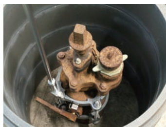
連結ボルト締付け状況
