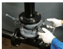
取り付け状況
