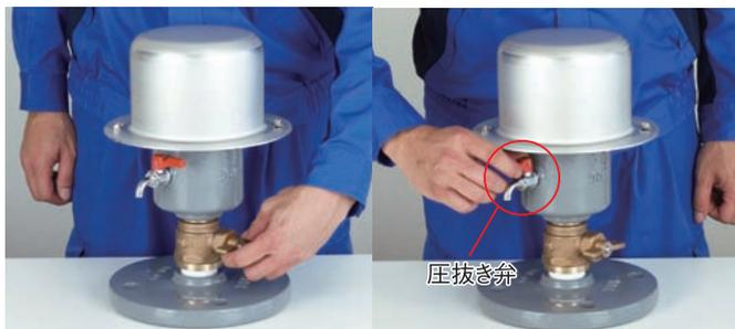
① ボール弁を**全閉**(フランジ形、フランジ形の場合は、補修弁を全閉)にしてください。
