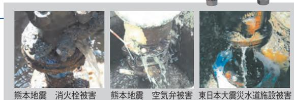
熊本地震 消火栓被害 熊本地震 空気弁被害 東日本大震災水道施設被害
