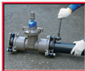
③メタルタッチするまでボルトを締め付けます。トルク管理不要。
