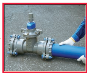
②管をバルブに挿入します。
