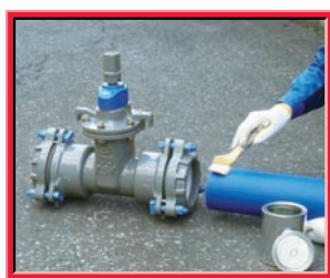
①インナーコアを管に挿入後、管挿し口及びバルブ受口に、メーカー指定の水道用滑剤を塗布します。
