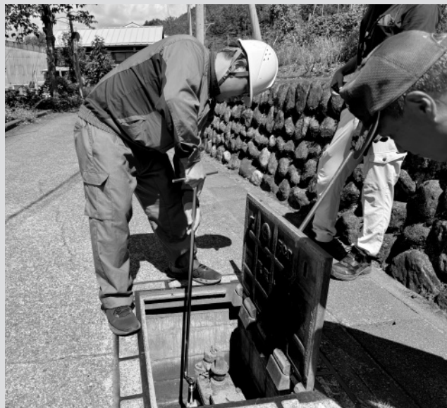
施工性の良さを現場で直接感じてもらうデモ施工も好評
