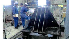
厚鋼板で衝突壁を製作
