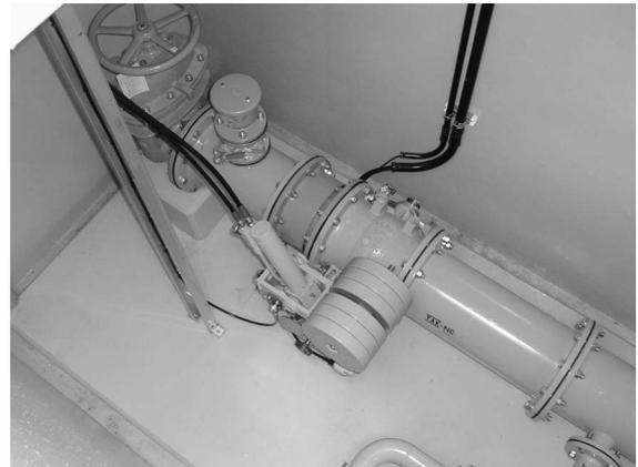
写真7 ウェイト式油圧分離形緊急遮断弁設置例
